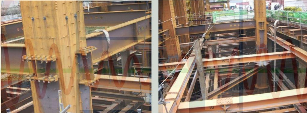
RC梁與鋼骨托梁之接合型式
