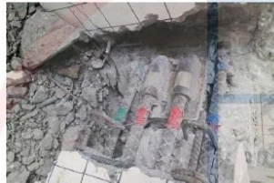
梁拱頭之梁頂續接器完整無損
