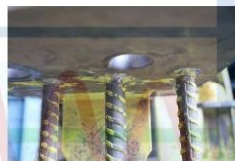
最右側梁主筋斷裂 (G1-1 試體破壞)
