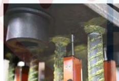
最右側梁主筋斷裂 (G1-5 試體破壞)
