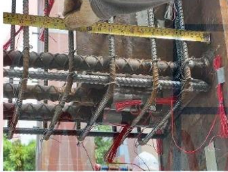
鋼筋綁紮及間距檢核
