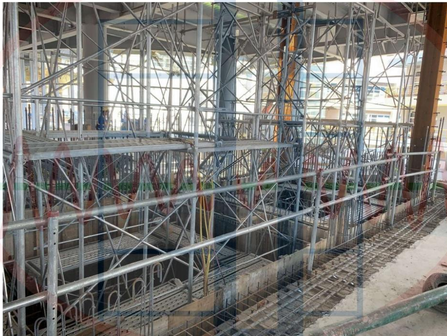
剪力牆施工照片
