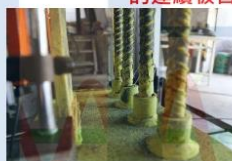
右側第二支梁主筋斷裂 (G1-2 試體破壞)
