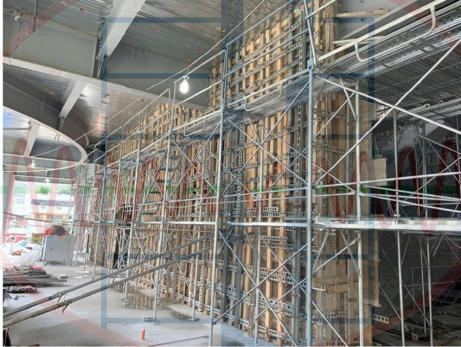
剪力牆施工照片
