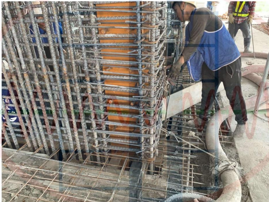
剪力牆施工照片
