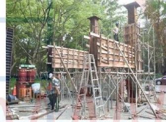
模板組立完成
